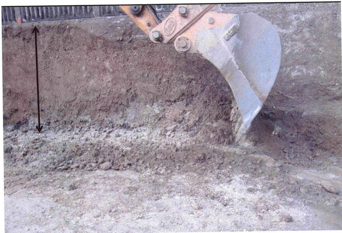
L'ouvrage en béton descend jusqu'au pied du barrage à environ 5.50 m
